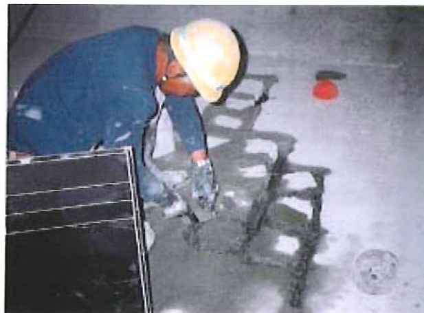
プラズマ止水施工状況
