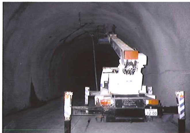
注入作業状況
