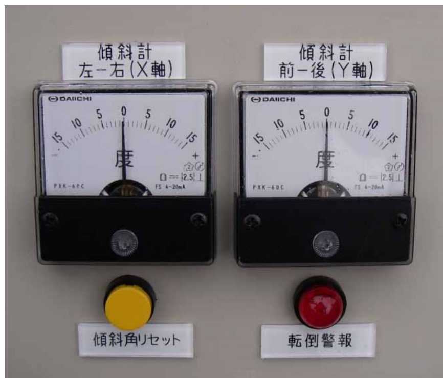
傾斜計確認状況
