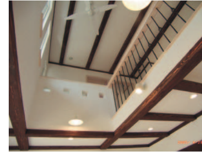
▲住宅建築研究所(愛媛県) 新築吹き抜けリビングライトイエロー
