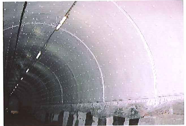
繊維シート貼ったトンネル覆工の補強と水抜き
