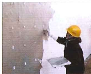
接着増強材塗布工
