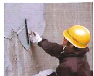
モルタル塗布工
