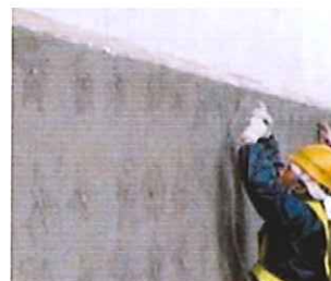
ラス網取付工
