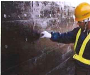
フックピン取付工
