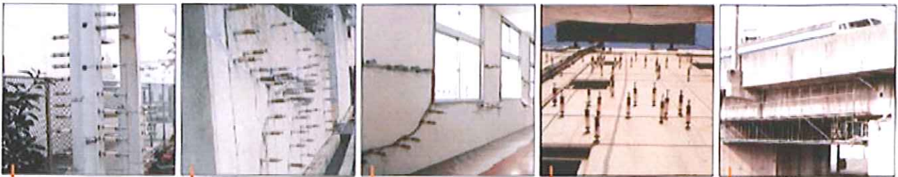
コンクリート柱
