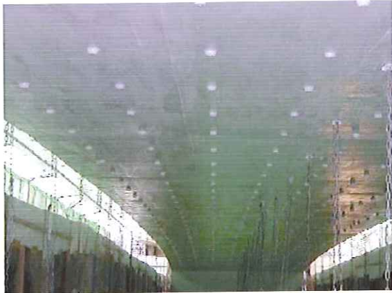
繊維シートを貼った鉄道・道路の高架橋の床版下面の補強と水抜き
