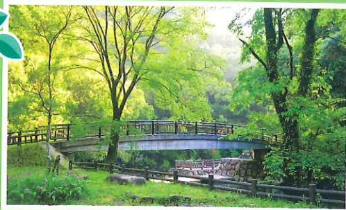
猪八重溪谷橋
