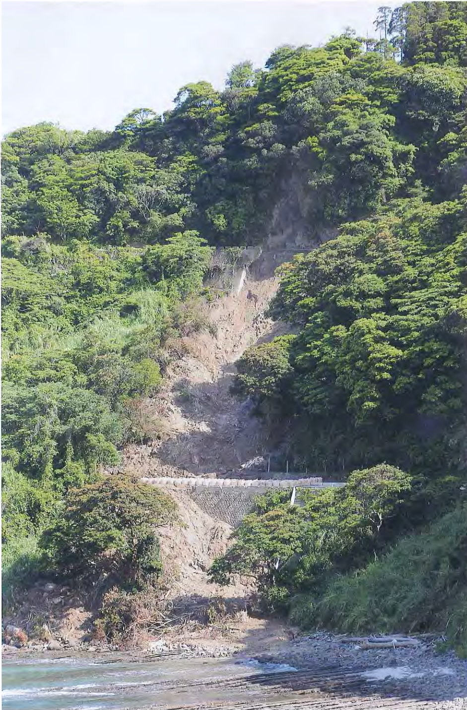
県道鵜戸神宮線で発生した土砂崩れ（平成22年4月撮影）
