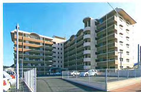
バリアフリーやオール電化の進む市営住宅
