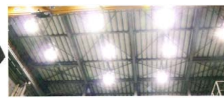
ペンダント(高天井用照明器具) ※写真左 設置例:工場内天井 ※写真右
