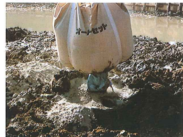
軟弱地盤安定処理 オートセットを散布
