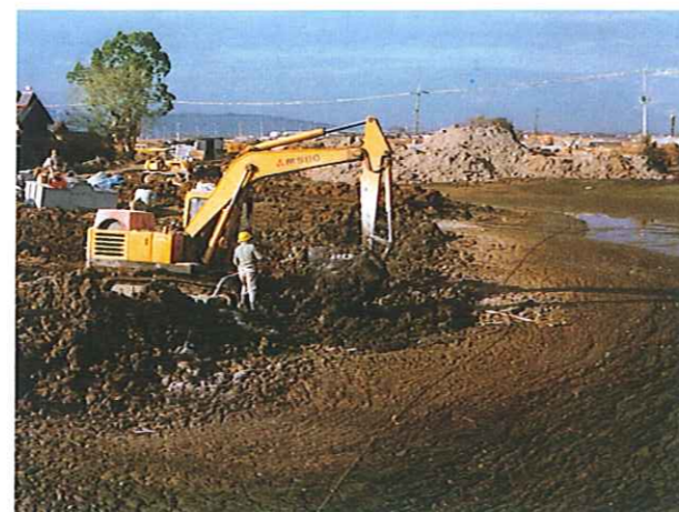
ため池底泥処理 ヘドロを固化処理しながら埋立て造成
