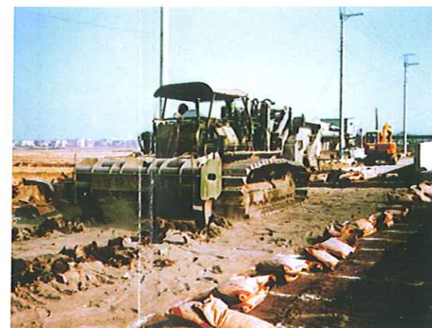
国道の路床改良 スタビライザーにてオートセットを混合
