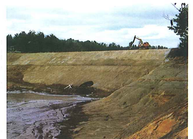
堤体法面処理 盛土材にオートセットを混合
