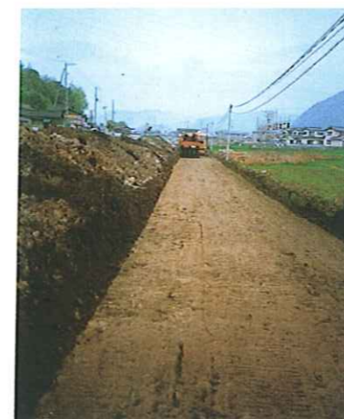
工事用進入路安定処理 旧水田部をオートセットで進入路に、安定処理を施工
